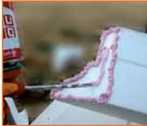
Зазоры между деталями необходимо оставлять от 2 до 5 мм. Для склеивания деталей между собой рекомендуется использовать полиуретановый клей (**Ceresit СТ 84, Penosil Fix&Go Montage** или **TYTAN Styro 753**).
