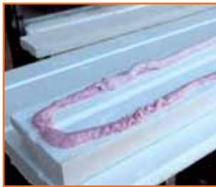
Обратную сторону элемента LEPNINAPLAST нужно обработать с помощью гребенки kleевым составом **Ceresit (СТ 83 или СТ 85)** либо другим аналогичным составом.
