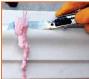
Макетным ножом срежьте излишки высохшего клея и в месте соединения справа и слева под углом сделайте фаску глубиной от 2 до 5 мм. Заполните канал с помощью эластичной шпатлевки CMC Izolasyon. После высыхания шпатлевки стыки нужно отшлифовать.
