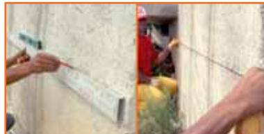
Перед монтажом крайне важно проверить несущие свойства фасадной стены – она должна быть сухой и ровной. Это проверяется с помощью отвеса, веревки и уровня (ватерпаса). Если обнаружатся неровности, отслоения и прочие дефекты, перед монтажом поверхность стены необходимо заштукатурить, при этом неровности стены не должны превышать  $\pm 10$  мм на 1 м<sup>2</sup>.
