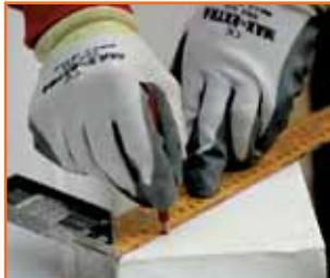
Поверхность, на которую будет осуществляться монтаж, необходимо подготовить, замерить и разметить. Затем измеряются и подгоняются под нужный размер элементы фасадного декора.
