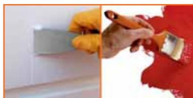
Когда шпатлёвка высохнет, стыки следует отшлифовать шкуркой. После того как все места стыковки изосайдинга, лепного декора и крепления дюбелей высохли и зашлифованы, изосайдинг легко грунтуеться водной грунтовкой и красится силиконовыми или акриловыми фасадными красками на водной основе (краски не должны содержать растворитель или ацетон).
